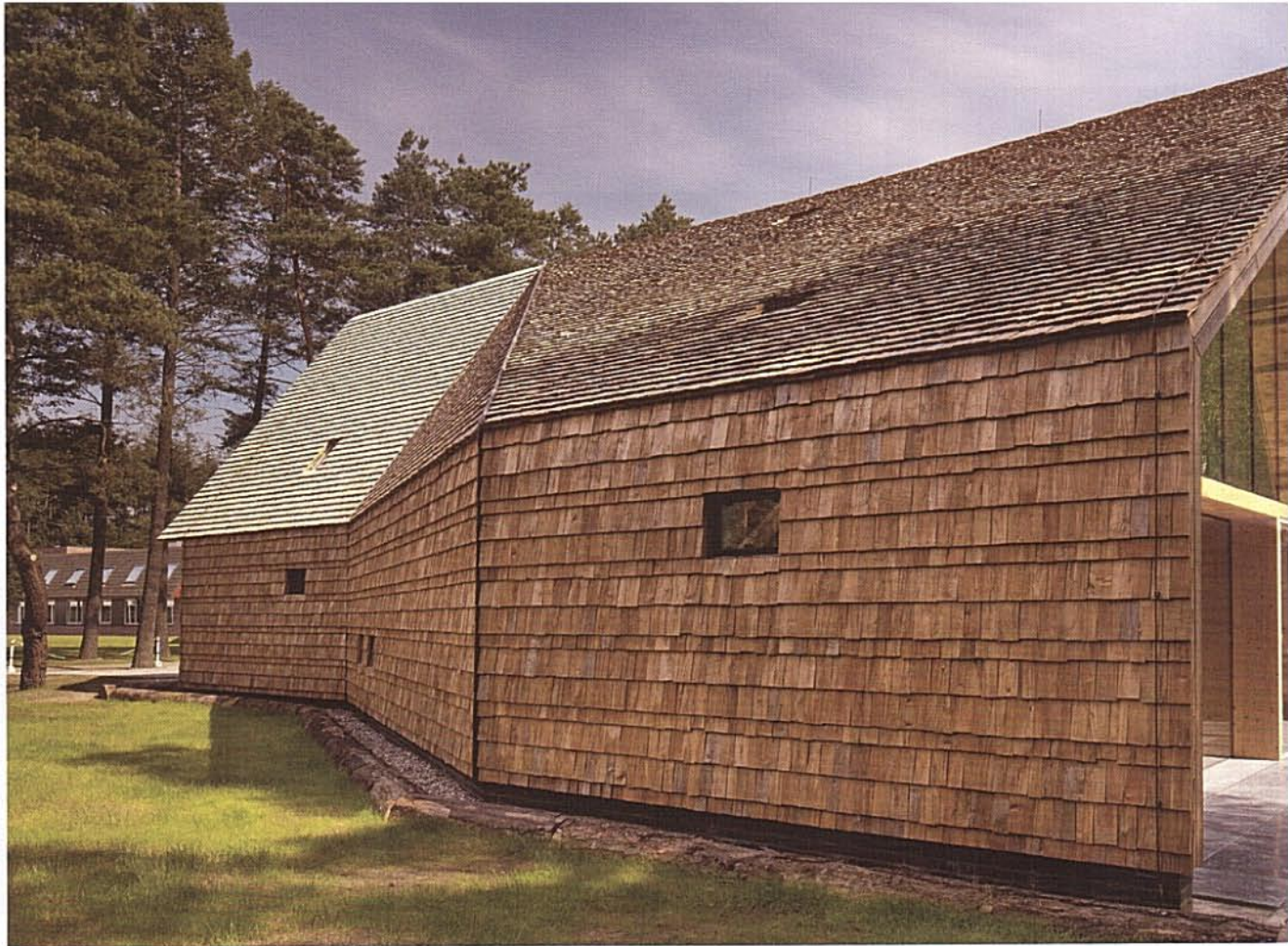
De kerk waaiert uit van 7 naar 11 m, van de entree naar de kerkzaal.
